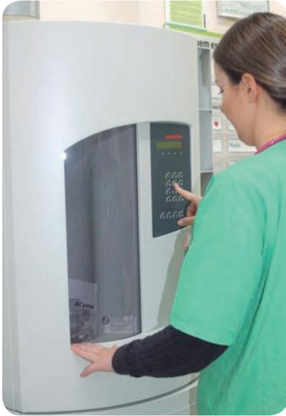
Já está em funcionamento no HMS – Hospital Dr. Miguel Soeiro, da Unimed Sorocaba, SP, um recurso inédito na região: o SCP – Sistema de Correio Pneumático, utilizado para transportar coletas de materiais que serão analisados pelo laboratório, medicamentos e laudos de exames. Nele, cápsulas circulam dentro de tubos pressurizados,
